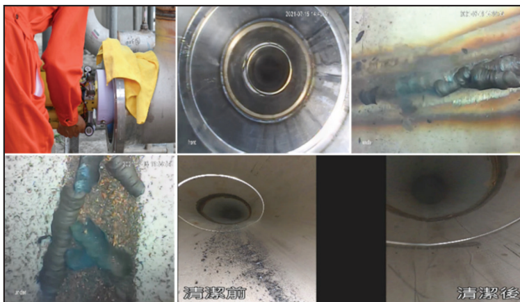
圖 5 管線清潔機器人拍攝影像
